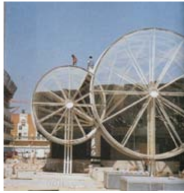
Grande Halle de Saint-Quentin-en-Yvelines Source : Maison de l'Architecture de Paris, Deslandes par Deslandes : Regards , Paris, A tempera, 1989, 68p.
