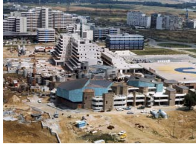
Construction du quartier des 7 mares, Elancourt, ville nouvelle de Saint-Quentin-en-Yvelines, Philippe Deslandes, 1972 Source : Site de la communauté d'agglomération de Saint-Quentin-en-Yvelines : http://www.saint-quentin-en-yvelines.fr/
