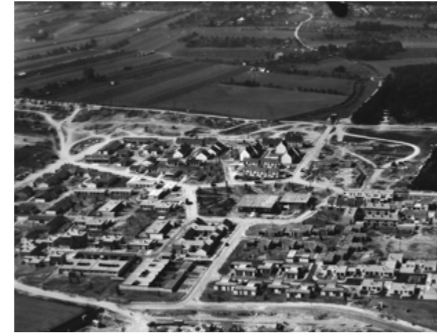
Travaux de construction du Villagexpo, St-Michel-sur-Orge, 1966 Source : Site du «Villagexpo : le quartier au il fait bon vivre !» disponible sur < http://www.villagexpo.fr/doku.php >
