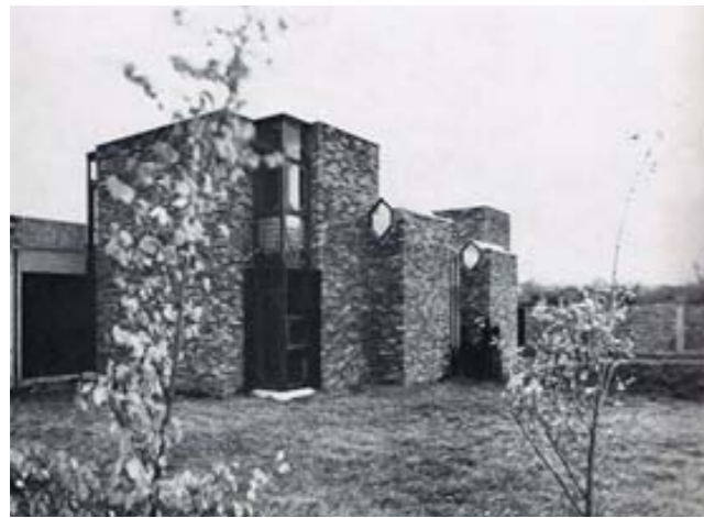
Résidence Ascot, Roissy-en-Brie, 1972 Source : Martine et Philippe Deslandes, architectes, Recherche et architecture n°13, 1973, pp23-39
