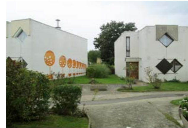
Ecart entre les maisons dû à une différence d'orientation, Elancourt Photo de l'auteur, octobre 2013
