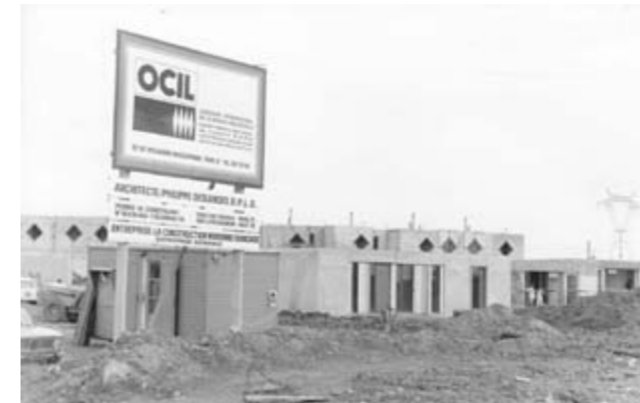
Chantier de la résidence Pré-Yvelines, Philippe et Martine Deslandes architectes, Elancourt, 1972 Source : Site de la résidence Pré-Yvelines disponible sur < http://www.preyvelines.com/ >
