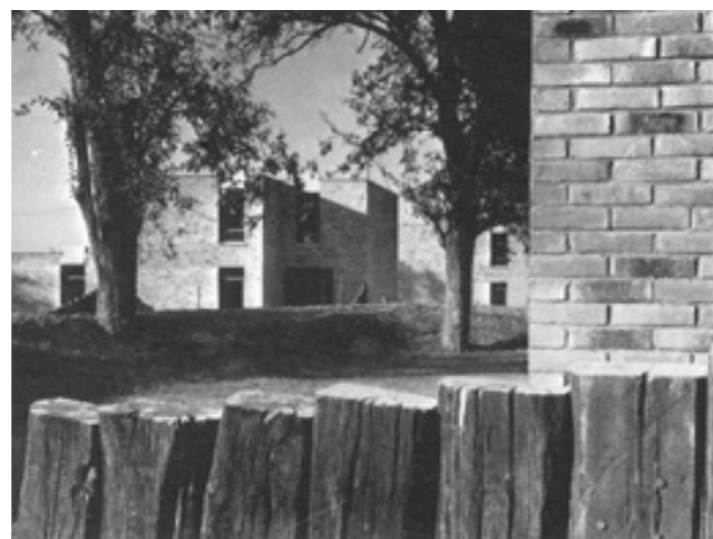
Résidence Les vallées, Bouffémont, 1975 Source : Site de l'Association les 3 mâts disponible sur < http://asl.les3mats.free.fr >
