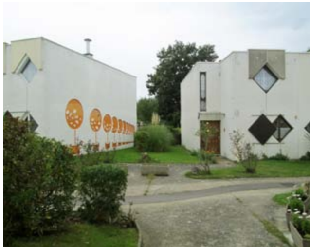
Fresque sur pignon de maison cylindre, Elancourt Photographie de l'auteur, octobre 2013
